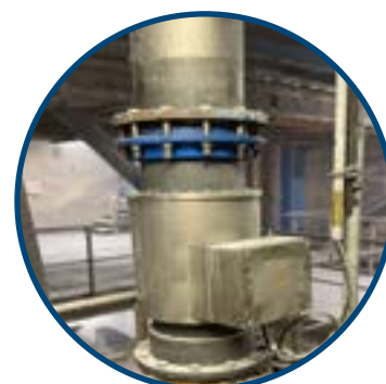
Катушка с измерительной платой (Корпус из нержавеющей стали)
