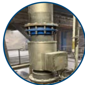
Spoel met meetplaat (Roestvrijstalen behuizing)
