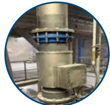
Spule mit Messplatine
