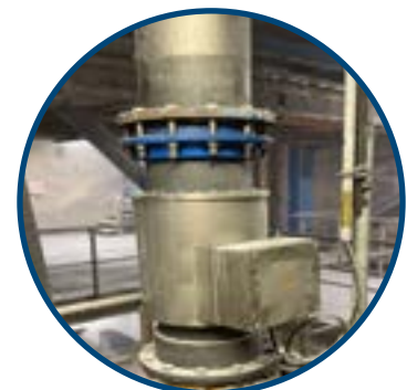
Bobine avec carte de mesure (boîtier en acier inoxydable)
